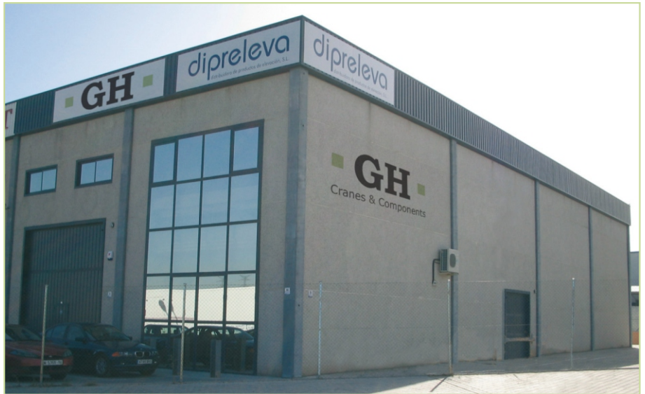
Centrum dysku, naprawa części i instalacji GH
