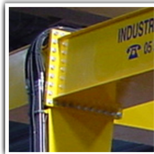
BOLTEDE SAMLINGER FOR NEM MONTAGE OG DEMONTAGE
