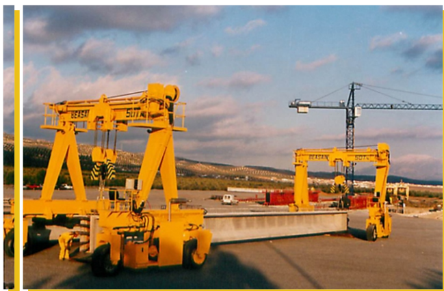
HÅNDTERING AF BETONBJÆLKER
