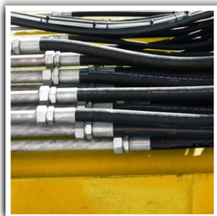
HYDRAULISKE RØRLEDNINGER AF RUSTFRIT STÅL
